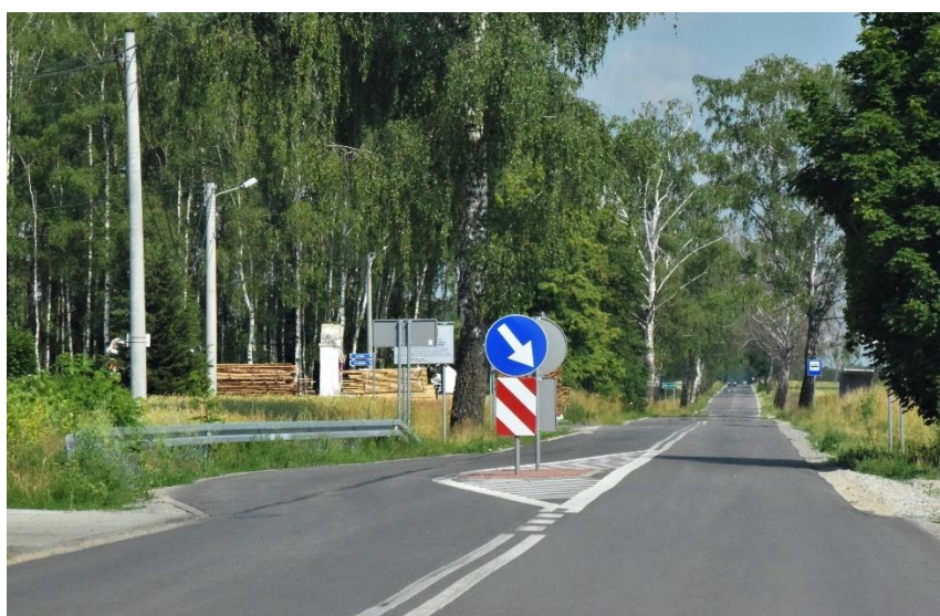
Fot. Zadanie zrealizowane w m. Rososzycyca-Wielowieś.
