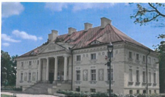
Fotografia 27. Widok na Pałac w Lewkowie
