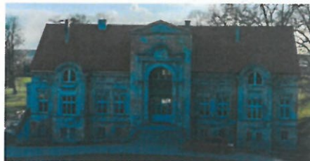
Fotografia 31. Widok na Dwór w Miedzianowie
