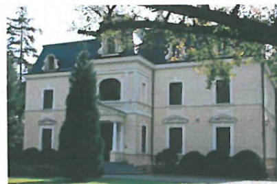
Fotografia 24. Widok na Pałac myśliwski w Bagateli
