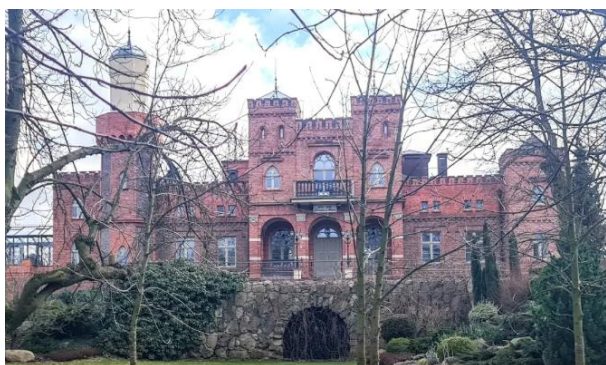
Fotografia 32. Widok na Pałac w Śliwnikach
