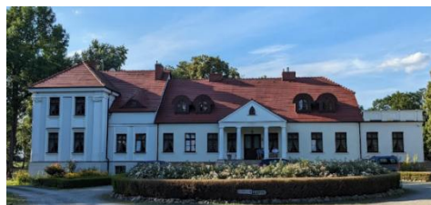
Fotografia 29. Widok na Dwór w Chotowie
