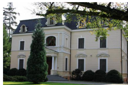
Fotografia 24. Widok na Pałac myśliwski w Bagateli
